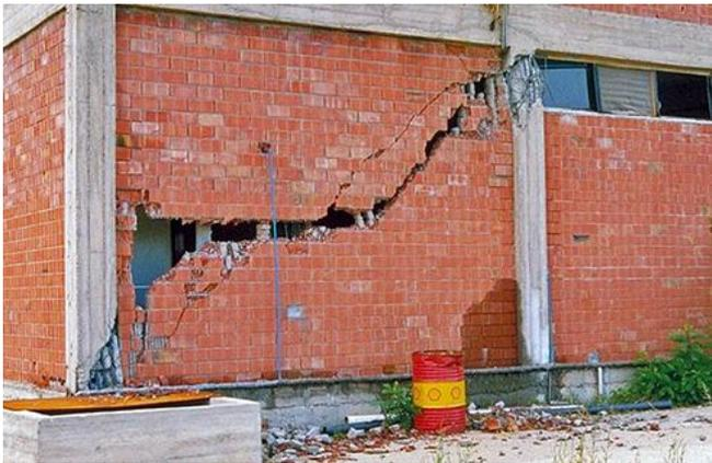
Abb. 2.4.1 > Druckdiagonale durch Mauerwerkswand und Schädigung der Stahlbetonstützen
