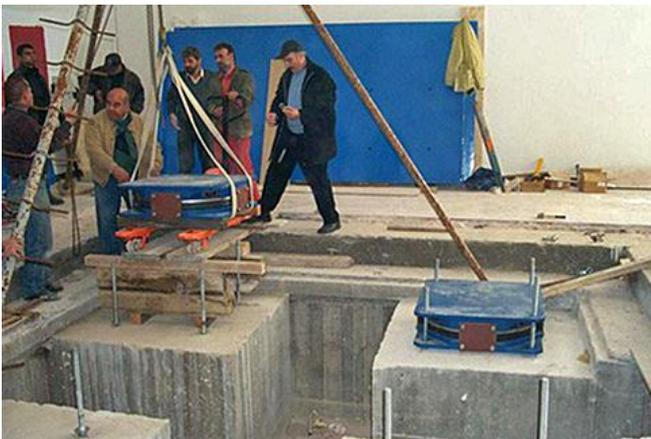
Abb. 2.25.6 und 2.25.7 > Schwingungsisoliertes Fundament für eine Skulptur
