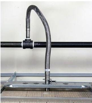
Abb. 2.12.3 > Flexible Abzweigung von Hauptleitung
