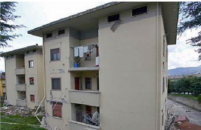
Abb. 2.6.3 > Brüstung im oberen Geschoss herausgefallen
