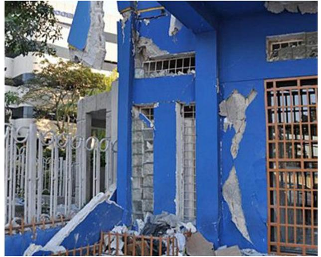
Abb. 2.8.3 > Schäden an Verglasung mit Glasbausteinen
