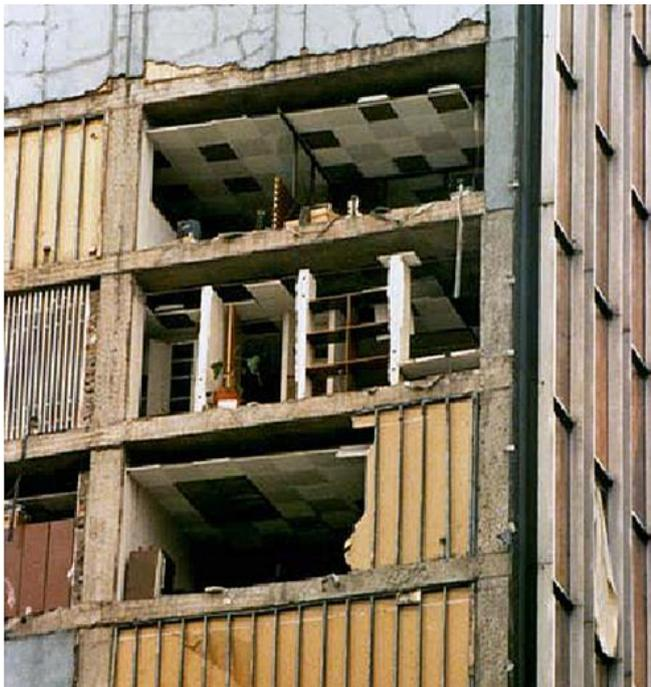
Abb. 2.5.3 > Versagen aus der Ebene einer vorgehängten Fassade
