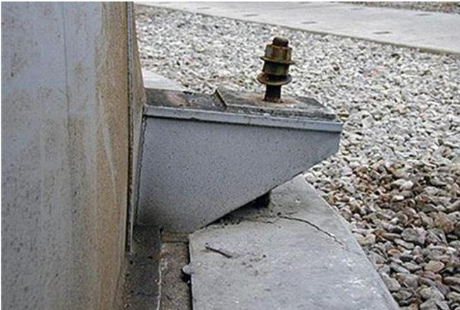
Abb. 2.17.3 > Beschädigte Verankerung
