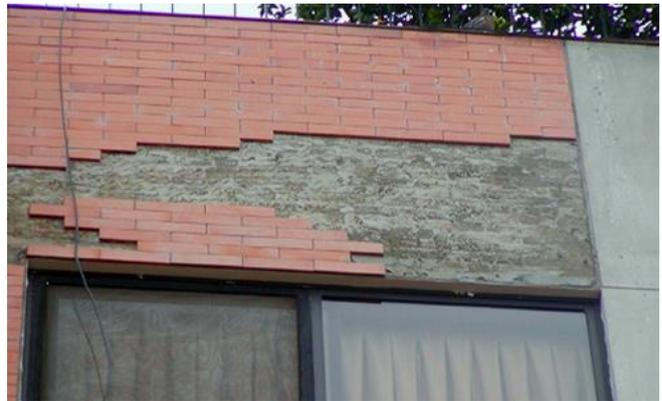
Abb. 2.5.2 > Ablösung von geklebten Elementen
