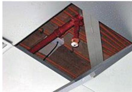
Abb. 2.12.1 und 2.12.2 > Beschädigter Sprinklerkopf
