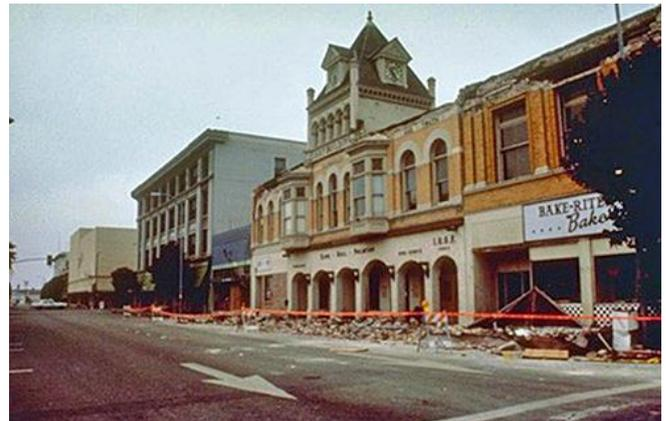
Abb. 2.6.1 und 2.6.2 > Versagen infolge Trägheitskräften quer zur Brüstungsebene
