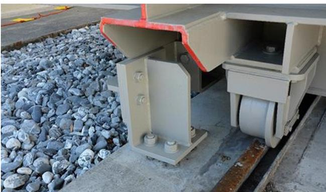
Abb. 2.14.3 > Verankerung eines Transformators auf Fahrrollen
