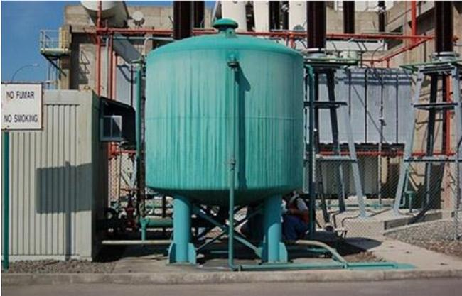
Abb. 2.17.5 > Aussteifung von aufgeständerten Tanks
