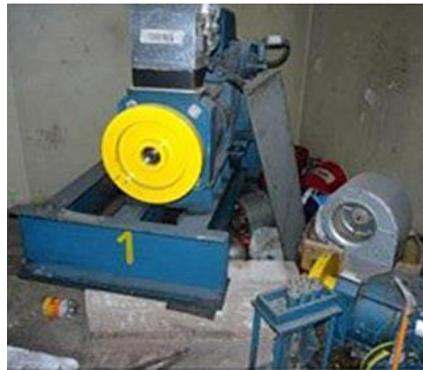
Abb. 2.19.2 > Ungenügend befestigte Antriebseinheit
