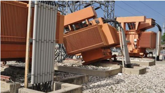
Abb. 2.14.1 > Umgekippte Hochspannungs – Transformatoren
