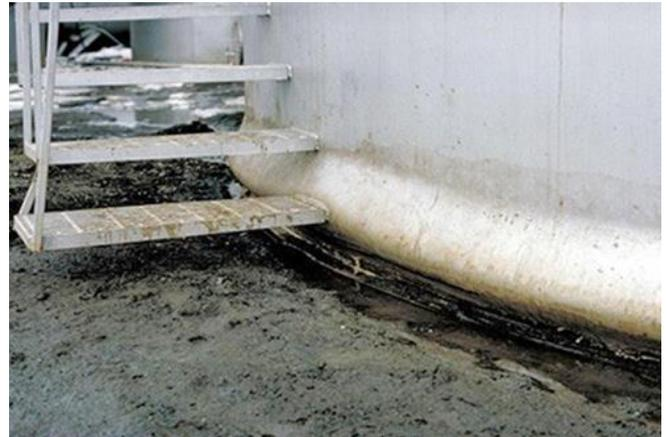
Abb. 2.17.4 > Ausgebeulte Tankwand (sog. «Elefantenfuss»)
