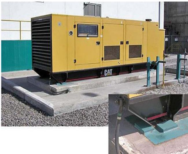
Abb. 2.16.7 > horizontaler Anschlag bei Generator
