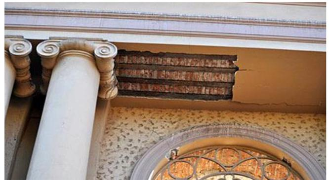
Abb. 2.10.3 und 2.10.4 > Abgelöste Deckenuntersicht und Abplatzungen in Verputz
