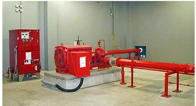
Abb. 2.12.4 > Verankerung der Pumpe und Steuereinheit, flexible Leitungsverbindungen und Wanddurchbruch mit Spielraum
