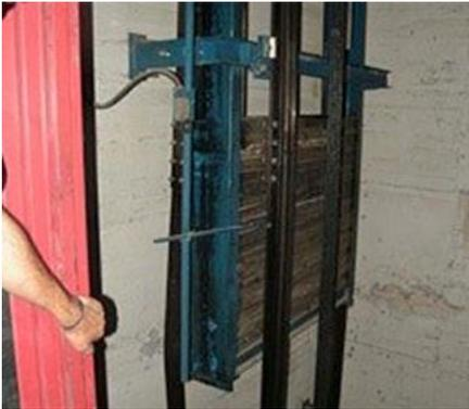
Abb. 2.19.1 > Führungsschiene durch Gegengewichte verbogen
