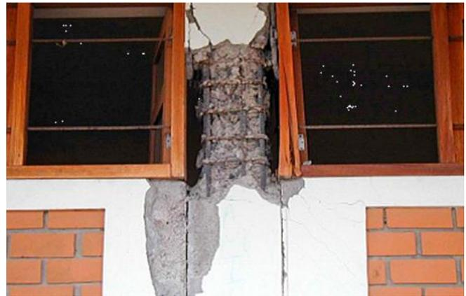
Abb. 2.4.2 > Schubbruch in kurzer Stütze bei Mauerwerksausfachung
