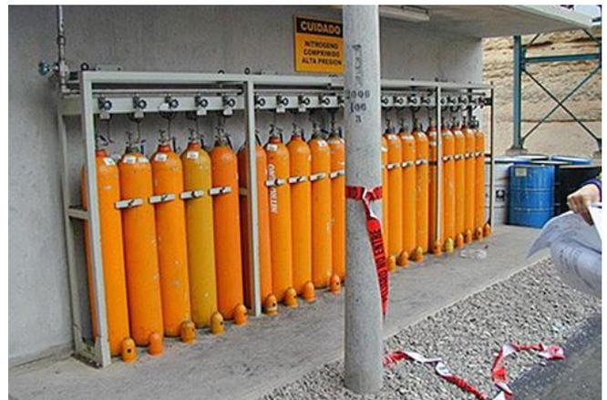
Abb. 2.17.8 > Befestigung von Zylinderflaschen
