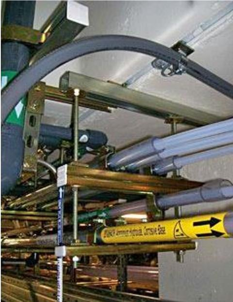
**Abb. 2.24.4** > Schutzhülle bei Abstützung in Querrichtung, Beschriftung des transportierten Mediums
