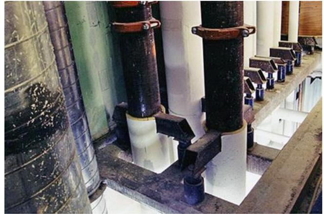
Abb. 2.18.11 > Lagerung von Steigleitungen bei Deckendurchbrüchen
