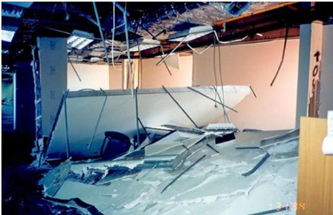
Abb. 2.4.3 und 2.4.4 > Schäden an Leichtbauwänden
