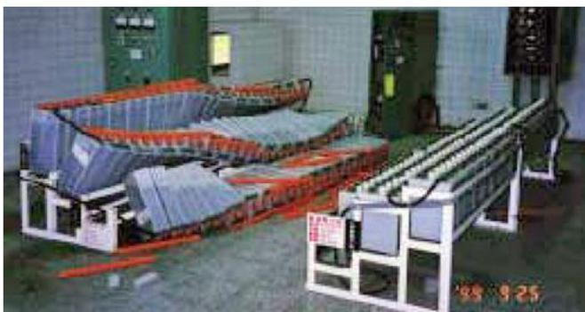
Abb. 2.11.1 > Schäden an Regal für Notstrombatterien und Herausfallen der Batterien
