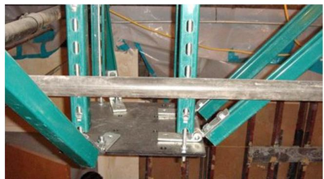
Abb. 2.15.4 > Aussteifung schwerer Leuchtkörper
