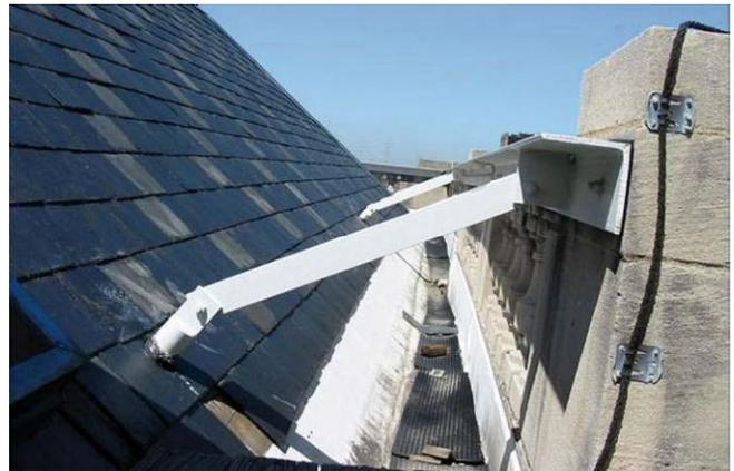
Abb. 2.6.6 > Massnahmen für Brüstungen auf dem Dach
