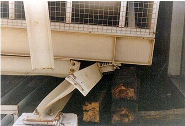
Abb. 2.16.3 und 2.16.4 > Gleitverschiebungen/Instabilitäten
