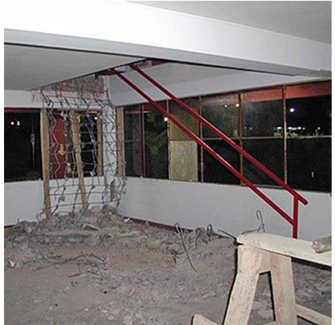
Abb. 2.7.1 und 2.7.2 > Druckdiagonalen im Treppenlauf
