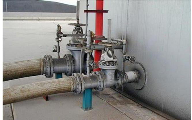
Abb. 2.17.6 > Flexibler Leitungsanschluss
