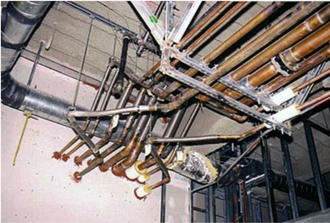
Abb. 2.18.10 > Flexible Verbindungen bei Wanddurchbrüchen, Aussteifung von Leitungstrasse
