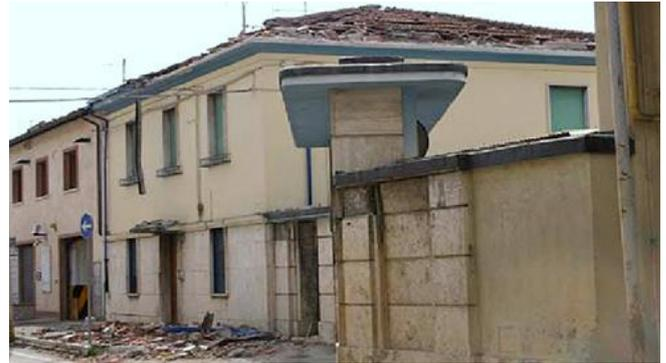
Abb. 2.10.2 > Heruntergefallene Dachziegel
