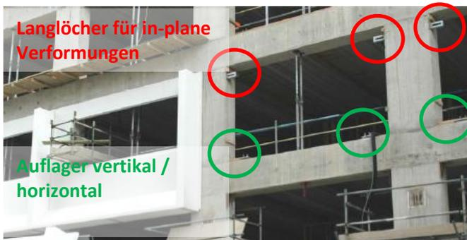
Abb. 2.5.5 > Befestigung von Fassadenelementen mit Langlöchern
