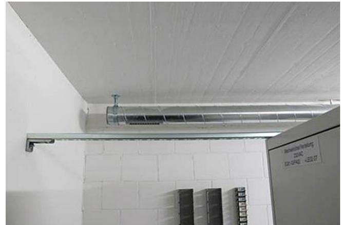
Abb. 2.13.6 und 2.13.7 > Sicherung von Schränken an der Wand
