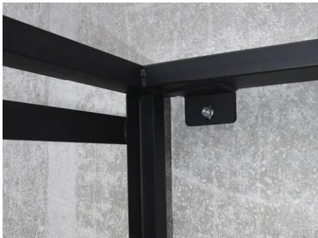
Abb. 2.3.7 > Befestigung Grundrahmen an Wand
